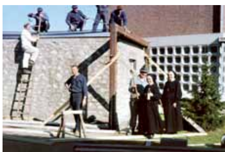
Bau des neuen Glockenturms vor der Kapelle.
